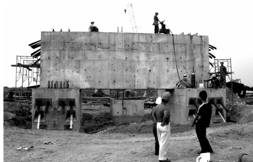
图 2 试桩反力系统
